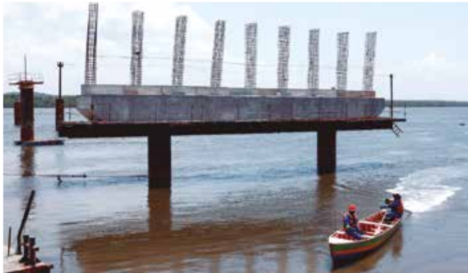
Complexo terá duas pontes, que somam 2,5 km de extensão
